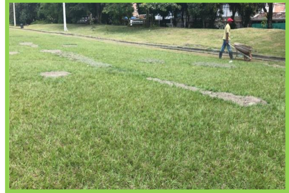
Construcción de bancas y pérgolas Ciudadela Comfandi
