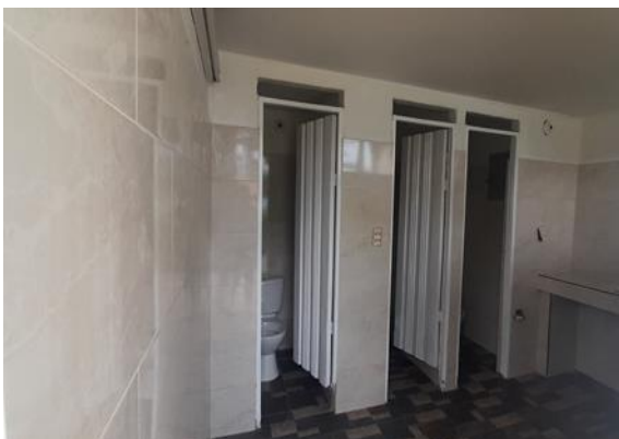
Remodelación de Baños Plazas Verdes
