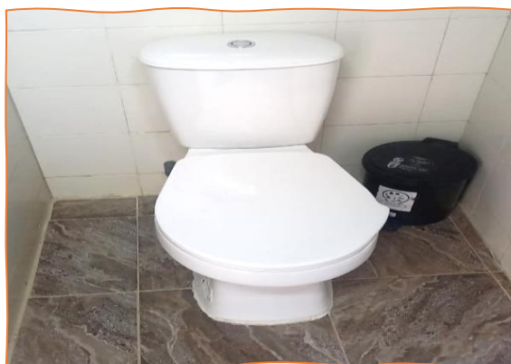
Adecuación baños La Estrella
