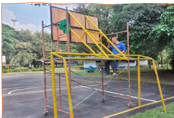
Construcción cancha de baloncesto P. del Amor
