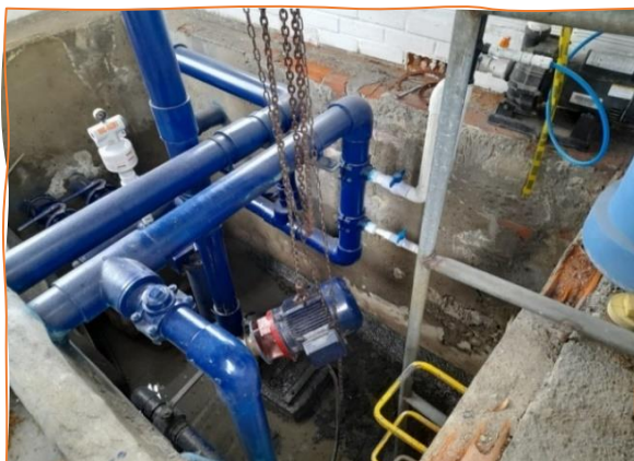
Instalación de motor cuarto de máquina
