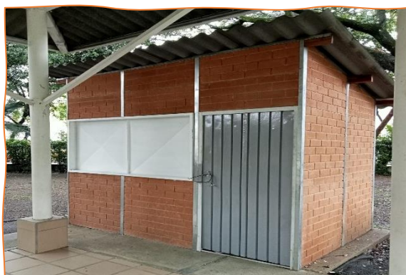
Construcción Cocineta – El Avión
