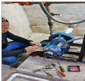
Mantenimiento de bomba de agua potable
